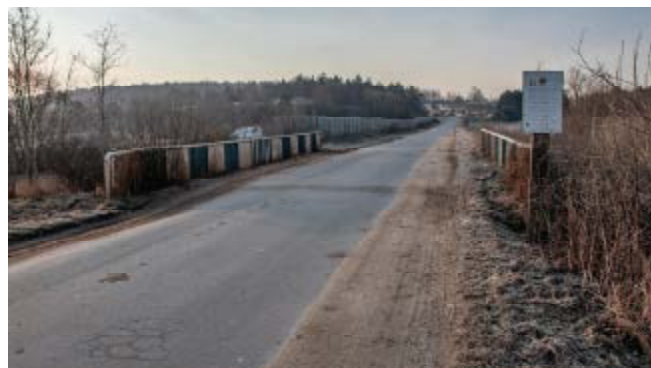
Na realizację długo wyczekiwanej inwestycji pozyskano aż 2,1 mln złotych rządowego wsparcia
