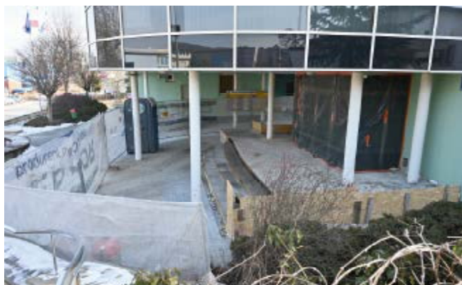
Pełną parą idą prace związane z modernizacją wejścia głównego
